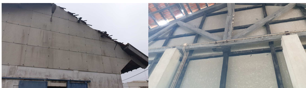
Figura 3.9 – Painéis em fibrocimento e estrutura de suporte (fachadas leste e oeste)
