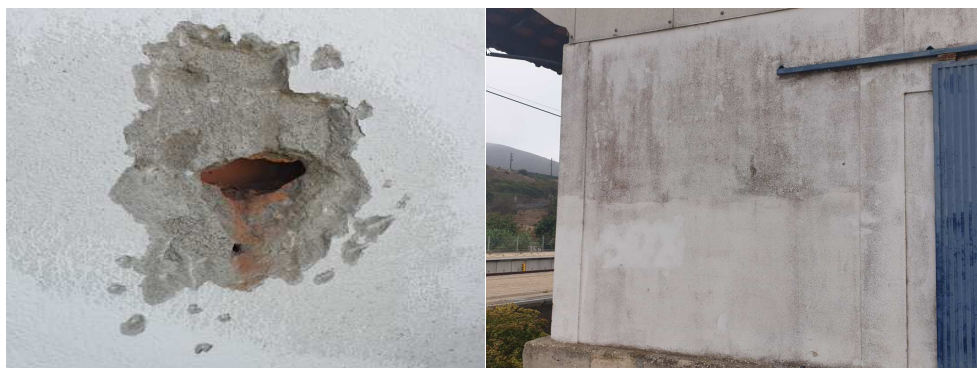
Figura 3.14 - Parede de alvenaria com interior de tijolos furados
