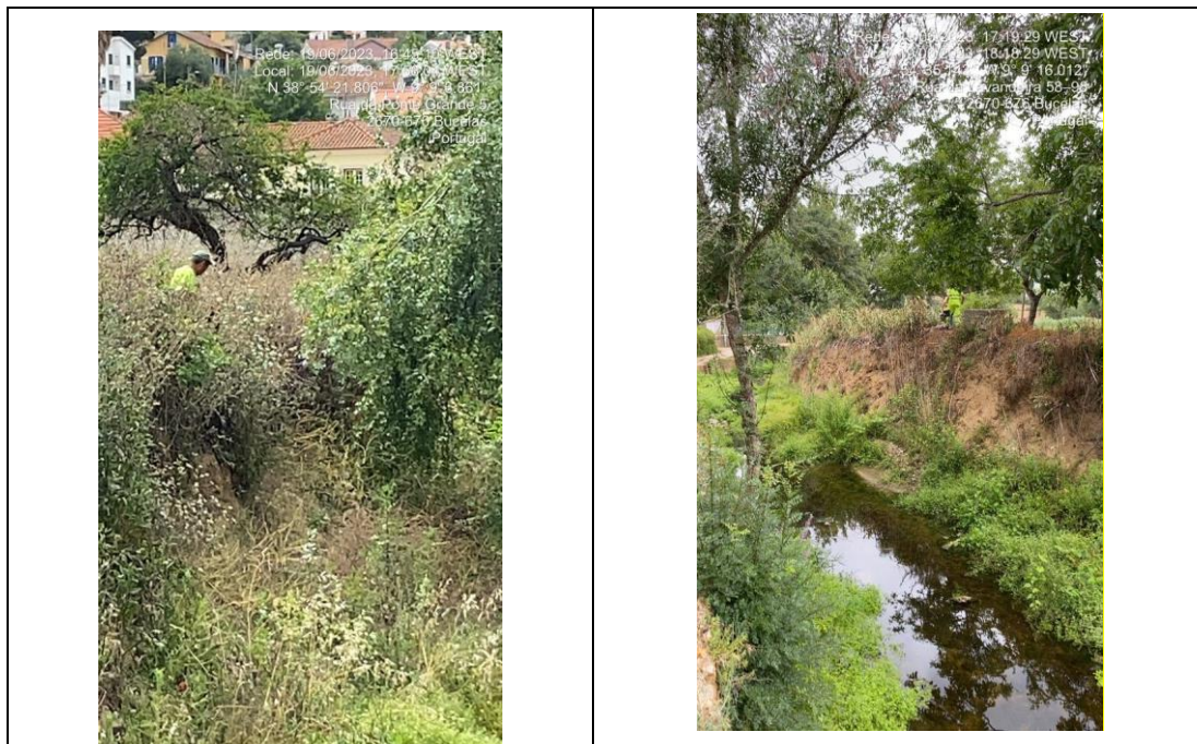
Fotos da obra – Antes e Depois
