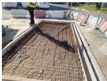
Construção da laje de betão e caleiras de drenagem
