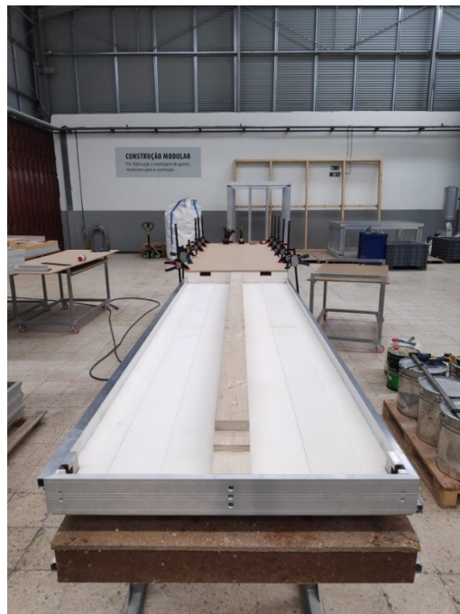
Figura 14. Estrutura de alumínio e viga lamelada para piso.
